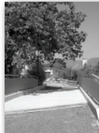
Blick in Richtung Quartier Oeschmatte von der fast fertig gestellten neuen Brücke über die Oesch
