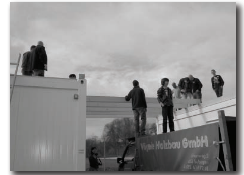
Die Dachkonstruktion entsteht...
